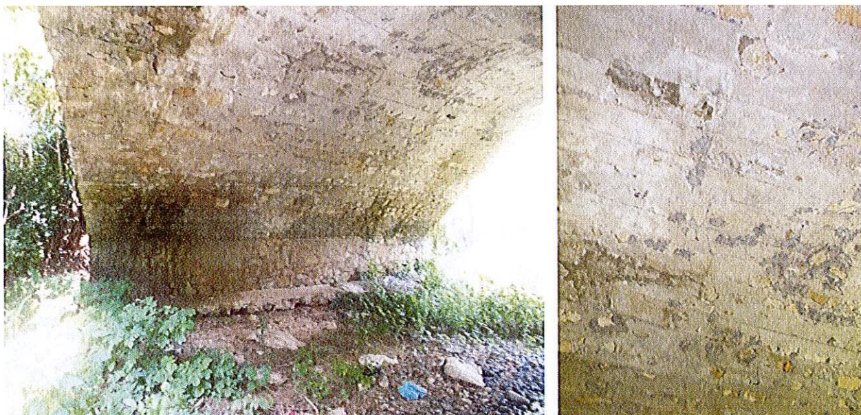
4. Vedere intrados și degradări ale la nivelul acestuia .
