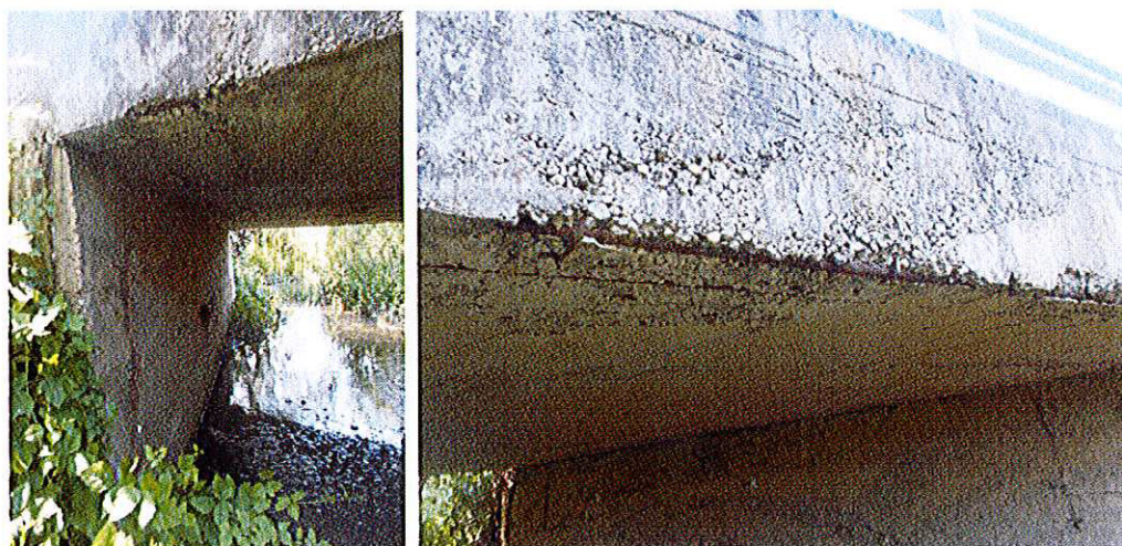
4. Degradări la nivelul dalei .
