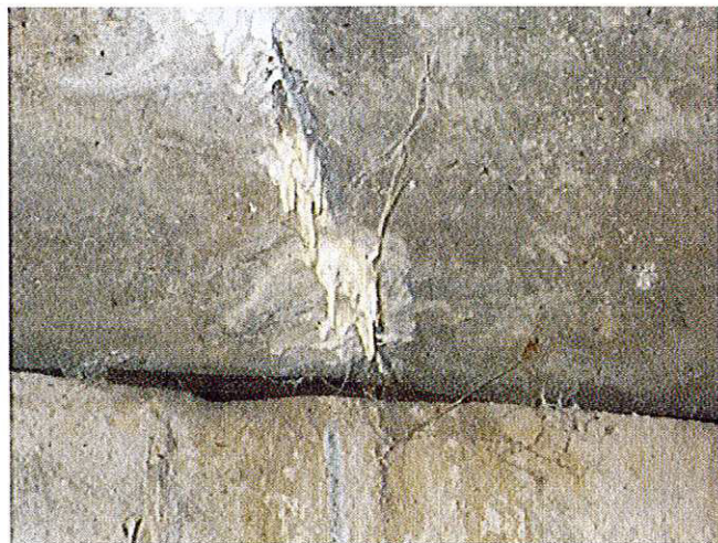
4. Degradări la nivelul intradosului (infiltrații și carbonatări).
