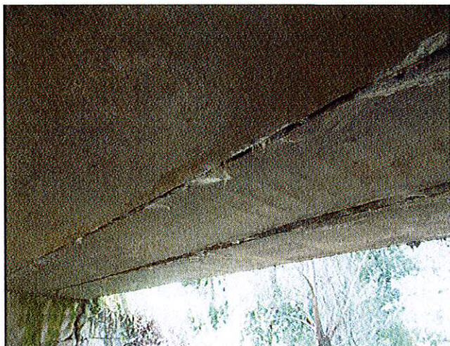
4. Degradări la nivelul intradosului (infiltrații și carbonatări).
