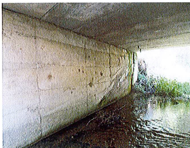
3. Degradări la nivelul elevației culeei mal drept.
