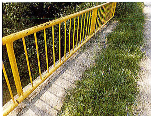
5. Coronament pod și prezența vegetației pe suprastructură.
