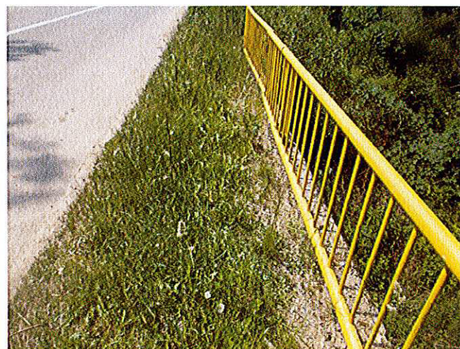
5. Coronament pod și prezența vegetației pe suprastructură.
