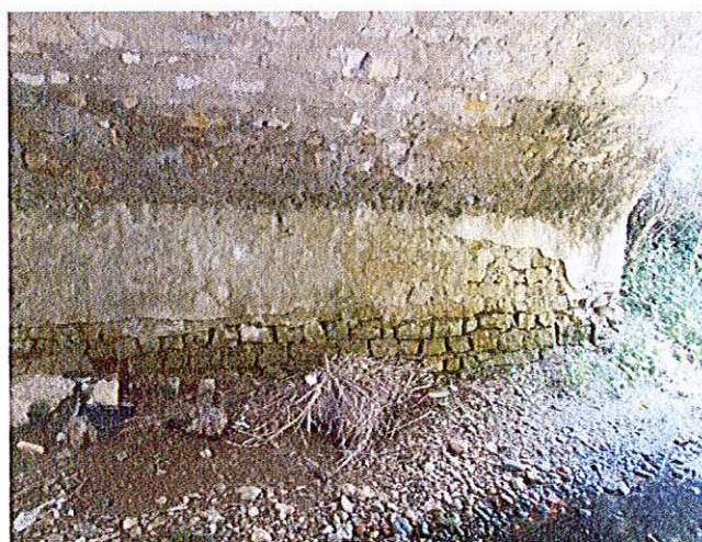
6. Degradări la nivelul fundațiilor.
