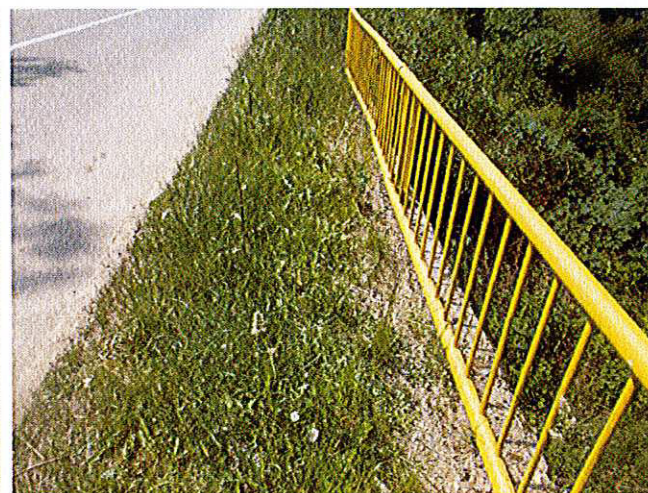
5. Coronament pod și prezența vegetației pe suprastructură.
