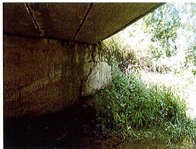
3. Degradări la nivelul elevației culeei mal drept.
