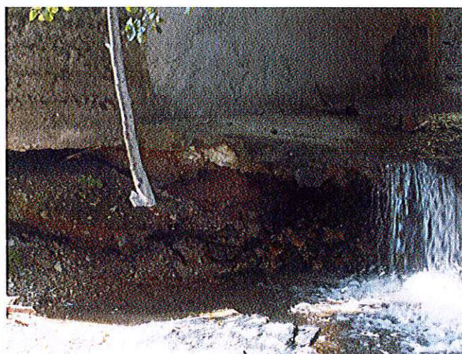
6. Vedere culee mal drept, pereu degradat și aripă aval cu fundația subspălată.
