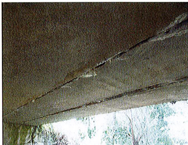
4. Degradări la nivelul intradosului (infiltrații și carbonatări).
