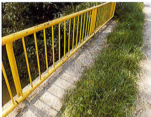
5. Coronament pod și prezența vegetației pe suprastructură.
